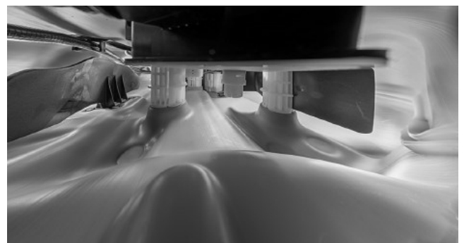
図10 タンクに内蔵された支柱の写真 4)
